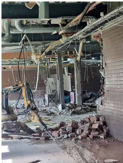
Rivning inför byggnation av ett nytt produktionskök i Kristianstad.
