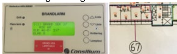
Figur 1. Brandinformationstablå till vänster och del av orienteringsritning till höger.
